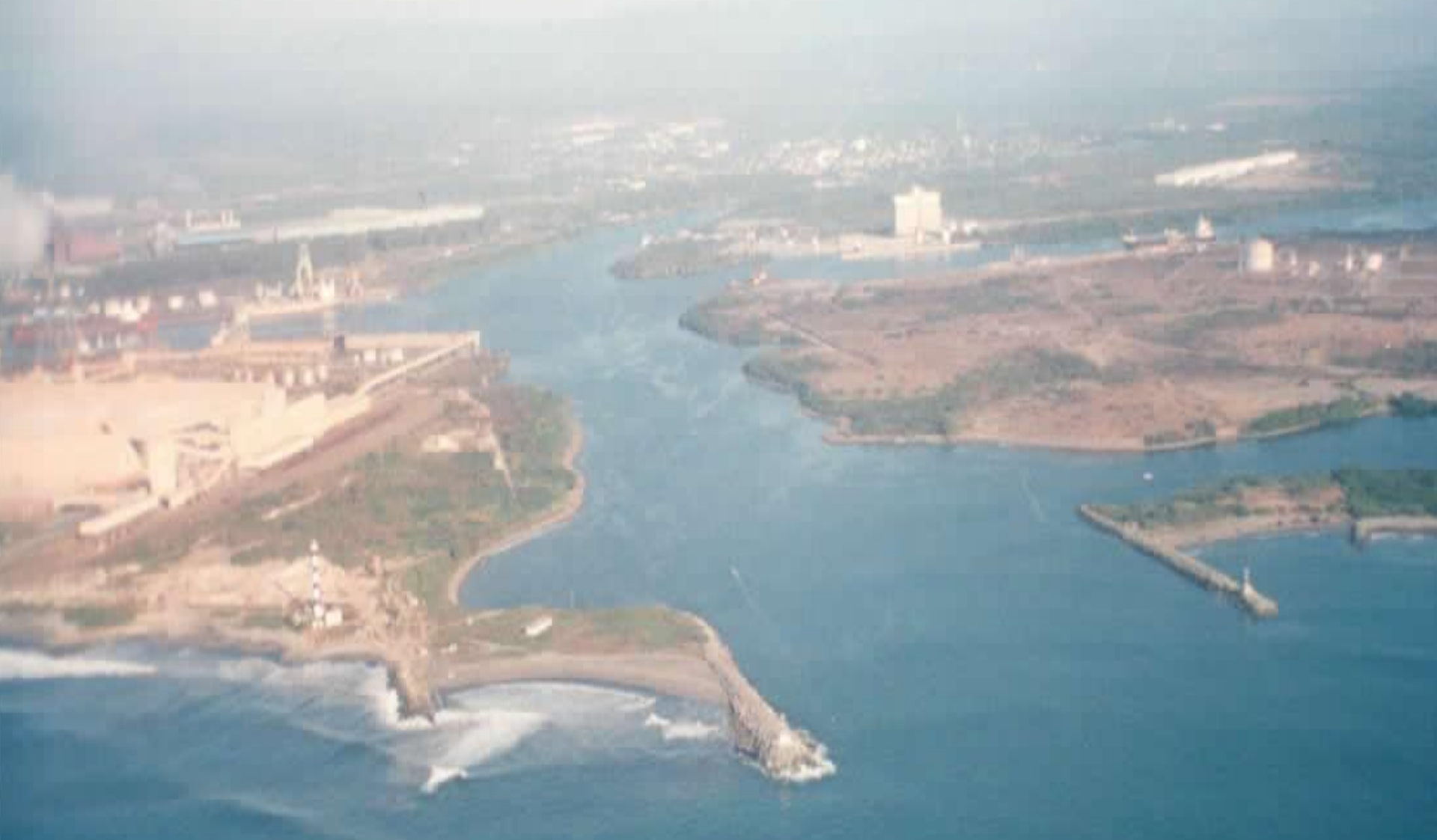
Obras de Protección del Puerto de Lázaro Cárdenas, Michoacán.
