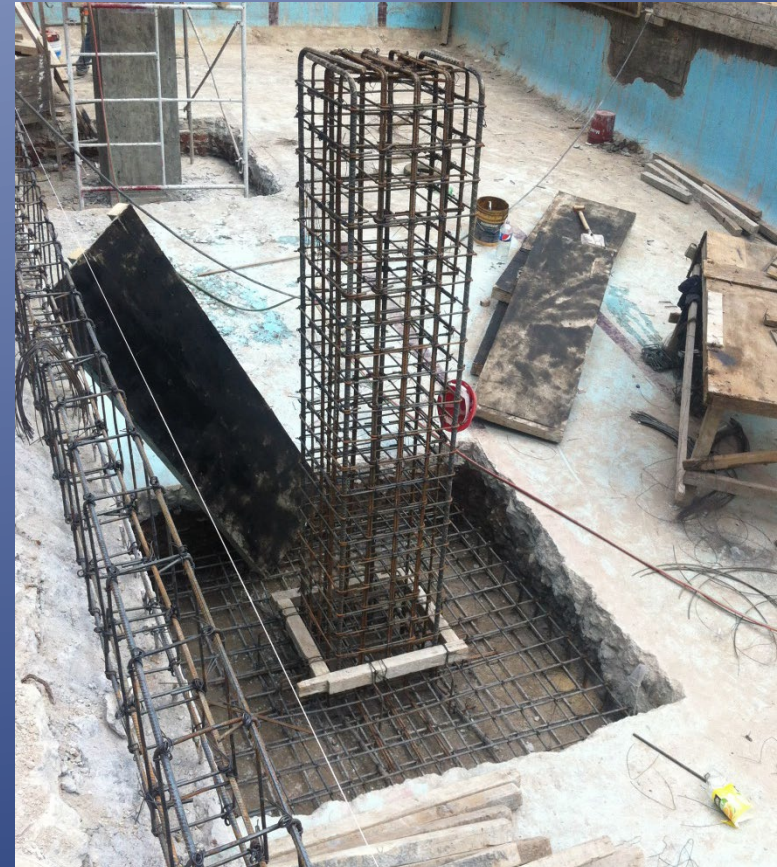
HABILITADO DE ACERO EN CIMENTACIÓN
