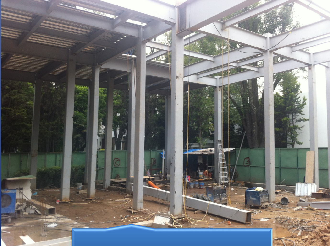
MONTAJE DE ESTRUCTURA DE ACERO
